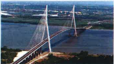
Pont de Normandie, France
